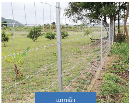
เสาเหล็ก
